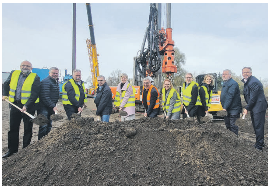
Voller Einsatz für den Schleusenbau: Beim offiziellen Spatenstich für die neue Schleuse Friedenthal packten viele Gäste mit an.
