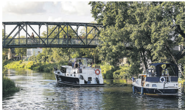
Jetzt kommt Bewegung in den Fluss: Durch die neue Schleuse Friedenthal entsteht wieder eine direkte Verbindung der Oranienburger Havel zu den Ruppiner Gewässern.
