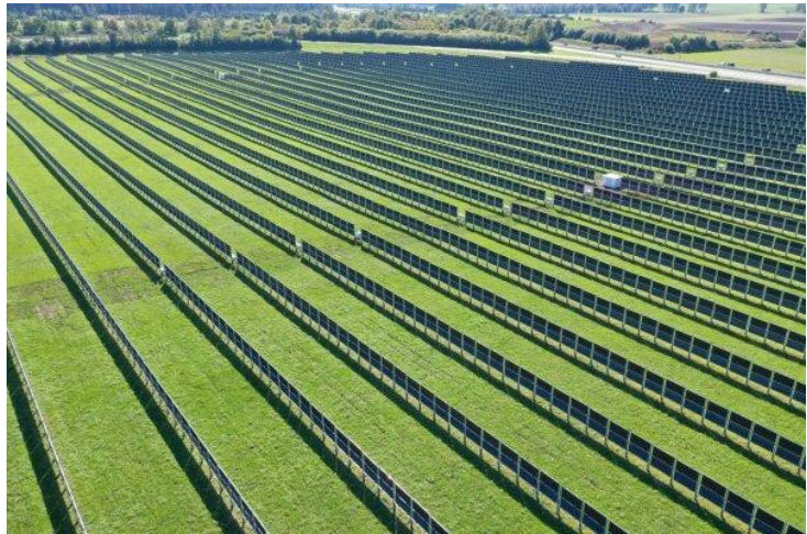
Abbildung 10: Vertikal ausgerichtete Agri-PV-Anlage (TFZ Bayern)
