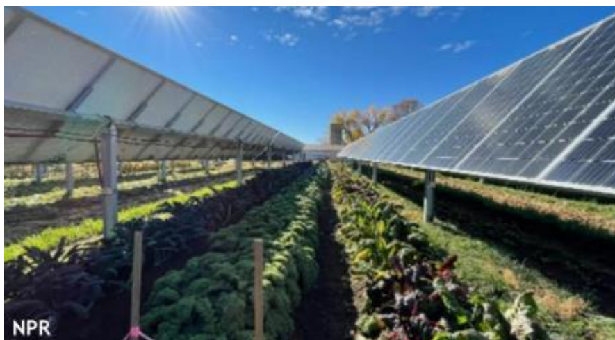
Abbildung 11: Bodennahe Agri-PV-Anlage
