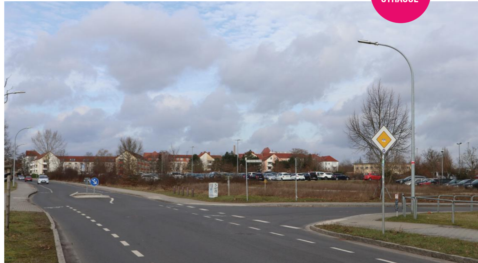
Abb. 127 Bestandssituation Lehnitzstraße (Blick Richtung Norden)
