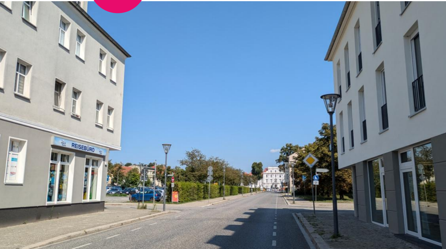
Abb. 99 Bestandssituation Berliner Straße (Blick Richtung Norden)
