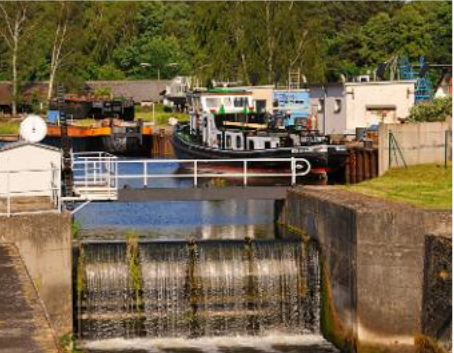
Abb. 251 Schleuse in Malz, Quelle: www.oranienburg.de © Frank Liebke
