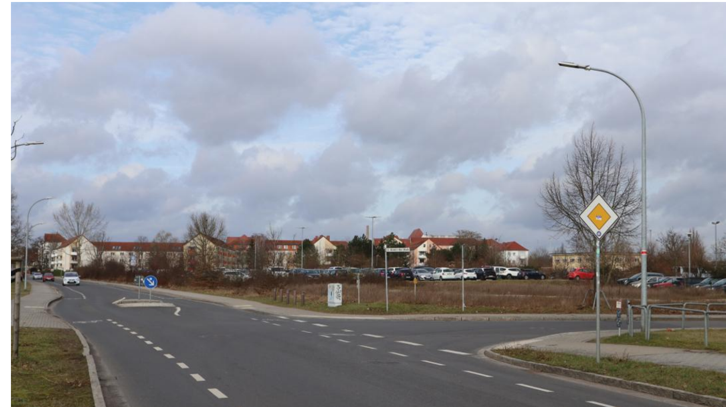
Abb. 181 Bestandssituation Lehnitzstraße (Blick Richtung Norden)
