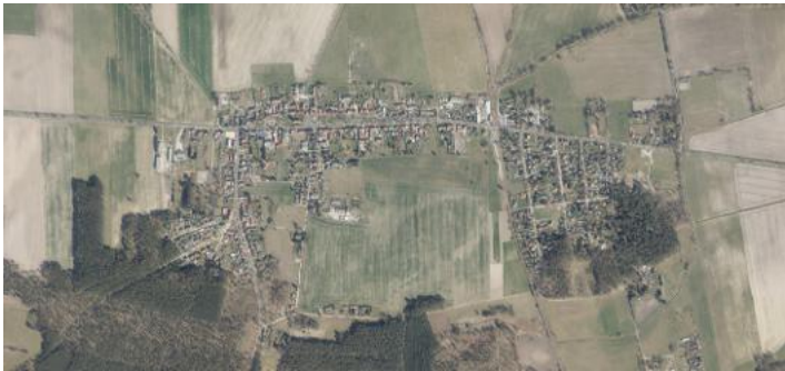
Abb. 243 Luftbild Ortsteil Wensickendorf
