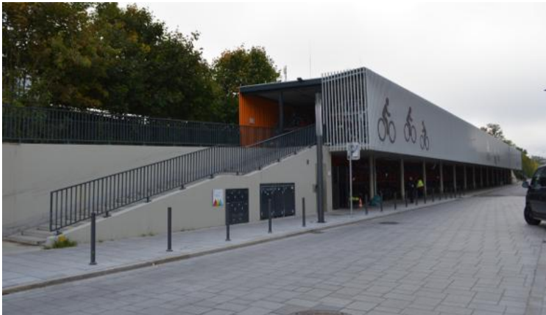
Abb. 269 S-Bahnhof Lehnitz Abb. 270 Fahrradparkhaus Bahnhof Oranienburg
