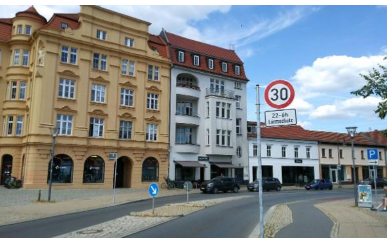
Abb. 90 Lärmschutz Bernauer Straße (Fotos Stadt Oranienburg)
