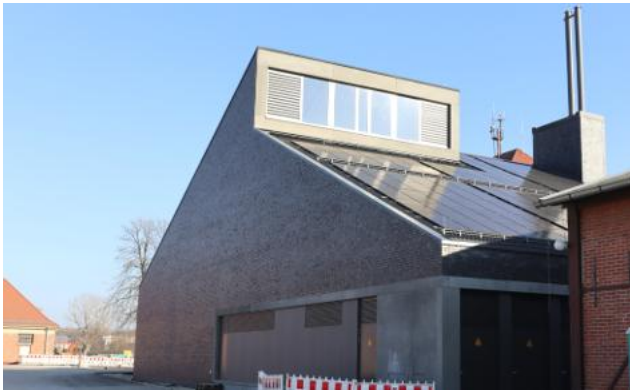
Abb. 267 Energiezentrale des kalten Netzes im Quartier Lagarde in Bamberg
