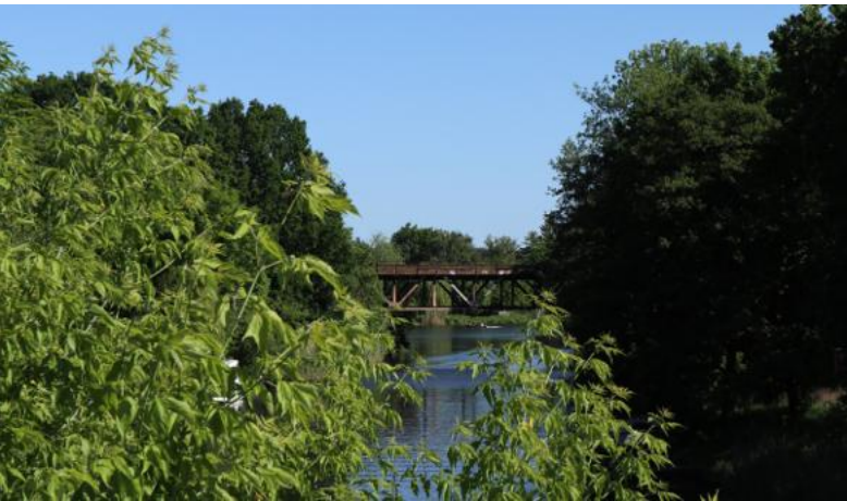
Abb. 172 Blick in Richtung Süden auf die ehemalige Bahnbrücke Abb. 173 Blick von der Brücke Lehnitzstraße in Richtung Süd-Westen Abb. 174 Verortung Maßnahme A4.1, A4.2, Legende S. 115
