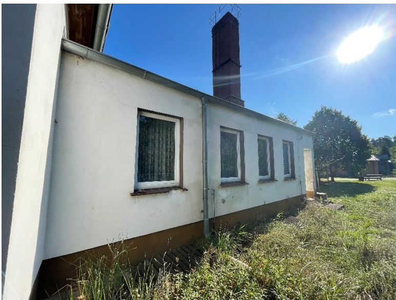
Abb. 2: Südseite des Heizhauses
