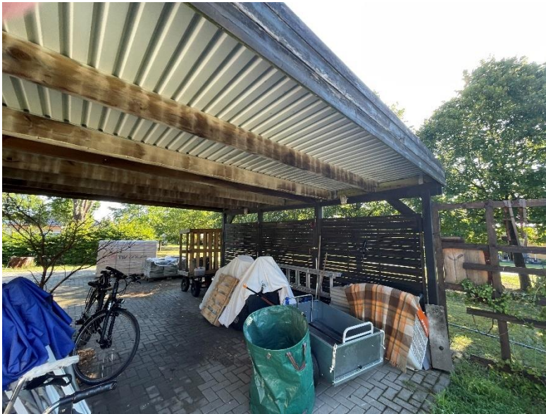
Abb. 3: Carport, angrenzend ans Heizhaus
