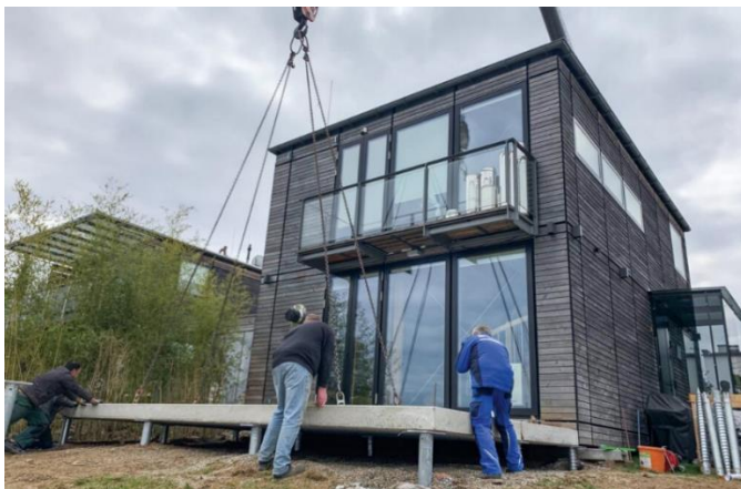
Abbildung 2: Schraubpfähle unter Stahlbetonbodenplatte
