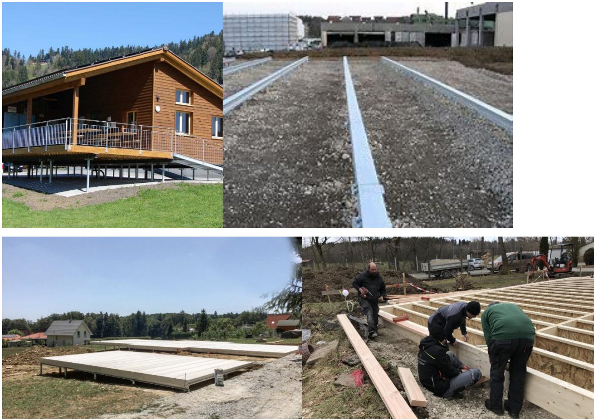
Abbildung 3: Schraubpfähle mit Unterkonstruktion nach Trägerrostprinzip
