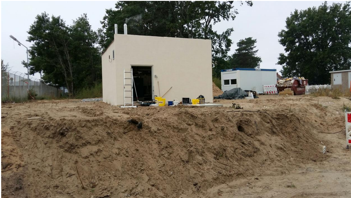
Foto 5: Zwischen den beiden Plangebietsteilen befindet sich die Trasse der ehem. Kremmener Bahn. Auf einer kleinen Fläche wird aktuell ein Blockheizkraftwerk errichtet.
