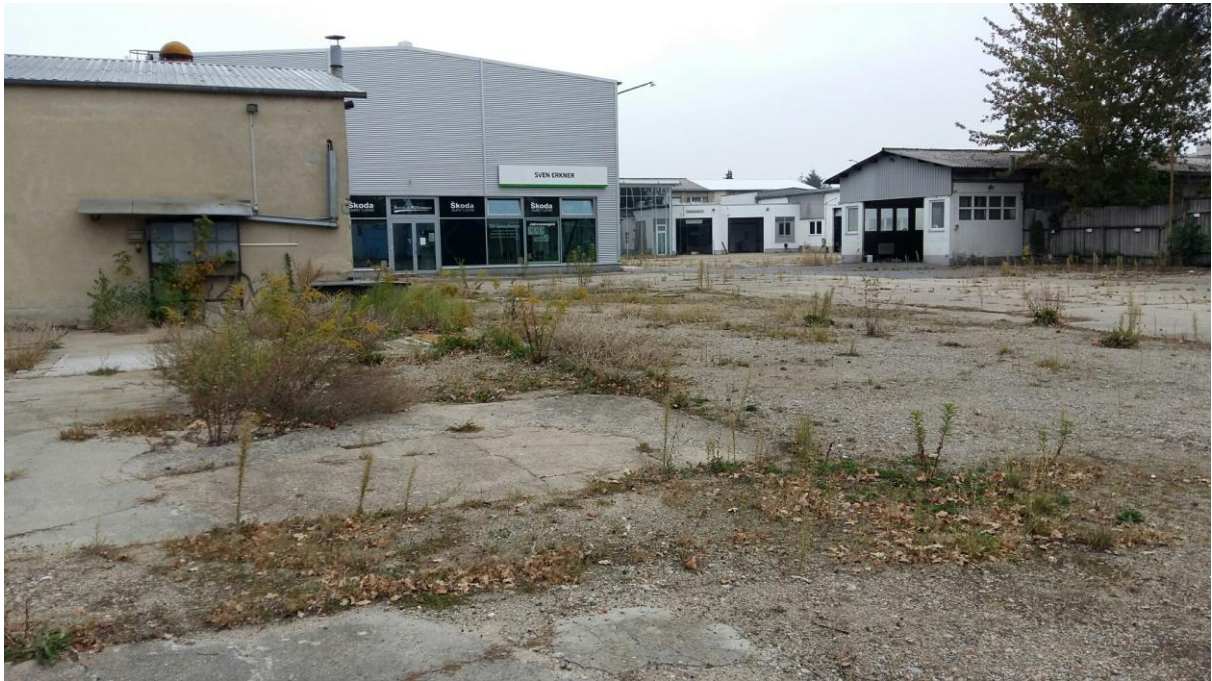
Foto 3: Ehemaliges Autohaus inkl. Werkstattgebäuden – im Vordergrund altes Bürogebäude.
