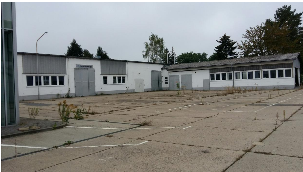
Foto 2. Werkstattgebäude im Plangebiet.
