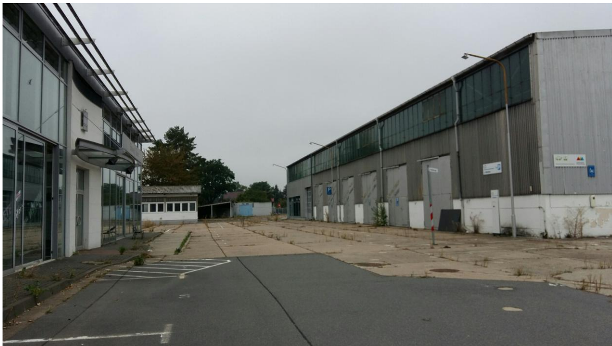
Foto 1: Ehemalige Autohaus und Werkstattgebäude – voll versiegeltes Grundstück.
